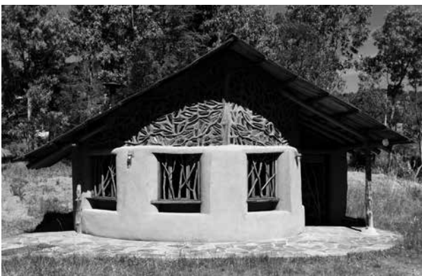
Figura 8. Pañetes de tierra expuestos a la intemperie en Tlaxco, Tlaxcala, México. Diseño de la Arquitecta Alejandra Caballero, Proyecto San Isidro. Fuente: Guerrero (2015).
