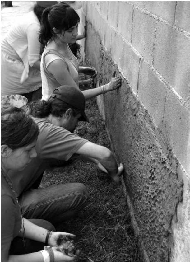
Figura 3. Aplicación de pañetes de tierra con mucílago de nopal sobre un muro de bloques de cemento. Taller comunitario realizado en Santiago, Nuevo León, México. Fuente: Guerrero (2015).
