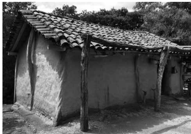
Figura 4. Las comunidades rurales conservan sus espacios habitables mediante labores periódicas de revestimientos con tierra, Ixtepec, México. Fuente: Guerrero (2015).
