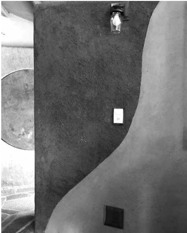
Figura 1. Los revestimientos de tierra brindan condiciones de confort al regular el flujo del vapor de agua. Obra de la Arquitecta Alejandra Caballero, Tlaxcala, México. Fuente: Guerrero (2016).
