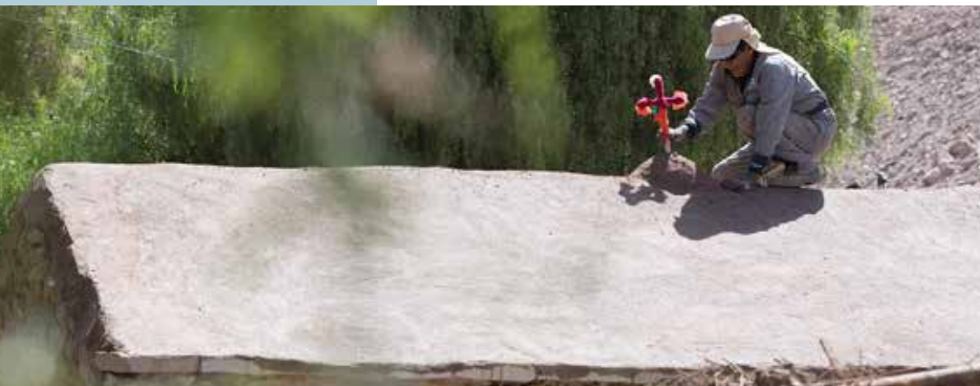
Restauración de techumbre tradicional.
