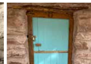
Restauración de puertas por equipo de Carpintería
