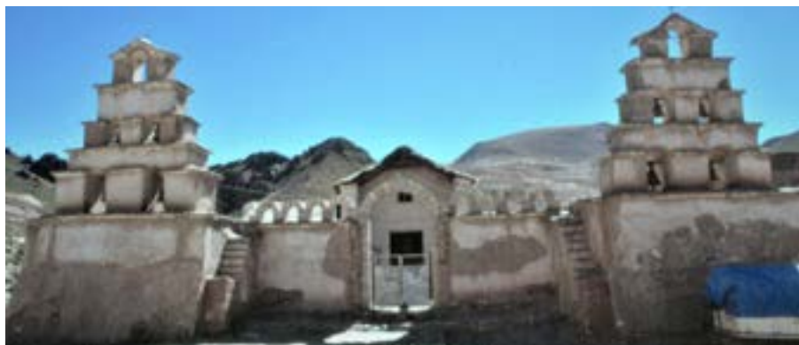
Fig. 4. Fachada del templo, en el que sobresalen los dos campanarios espadañas de 3 cuerpos
