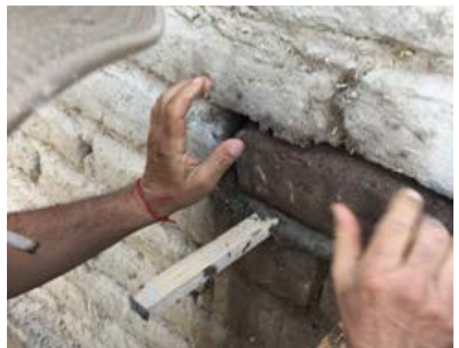
Instalación calzaduras de adobes
