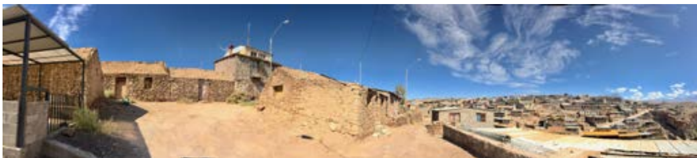
Vista ladera oriente del Poblado de Ayquina, se muestra el estado de transformación e hibridación de la arquitectura antigua con las intervenciones actuales y la irrupción de viviendas disonantes. Registro propio (2022)
