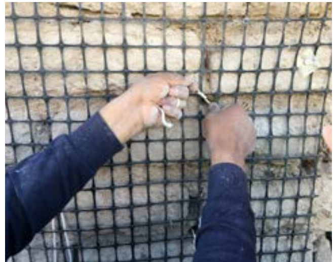
Instalación de geomallas
