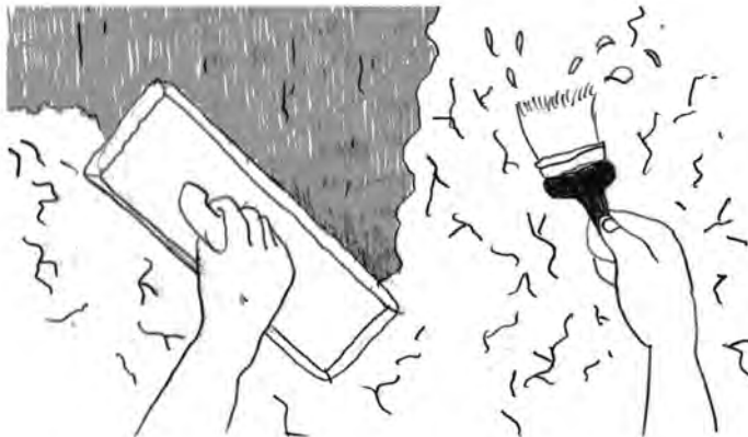
La segunda capa cubre las pequeñas fisuras e imperfecciones de la capa anterior. Recordar humedecer la capa anterior antes de aplicar la segunda.
