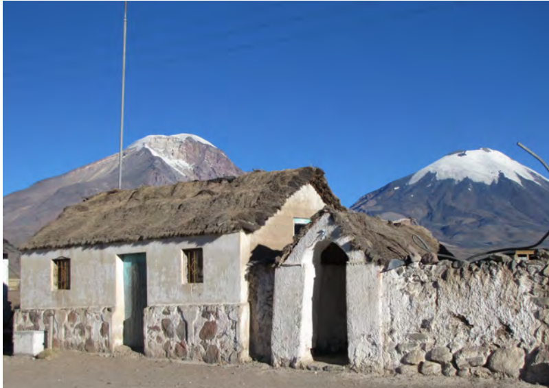
Vivienda tipo en el poblado de Caquena. Zócalos de piedra, muros de adobe y cubierta de paja brava.
