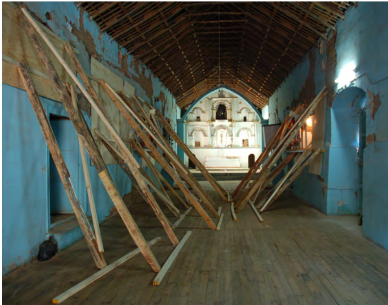
Apuntalamiento de emergencia del templo de San Francisco de Asís de Socoroma posterior al sismo del 2005.
