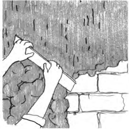
Emparejar la superficie con una regla de madera mojada y dejar secar
