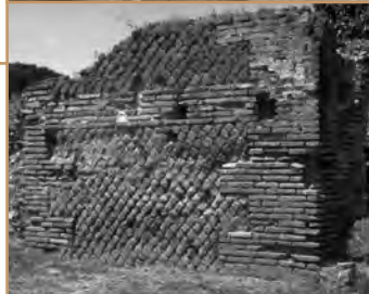
Muro de piedra reticular. Pompeya, Italia
