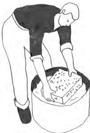
Sumergir los adobes en un recipiente con agua antes de ubicarlos en el muro
