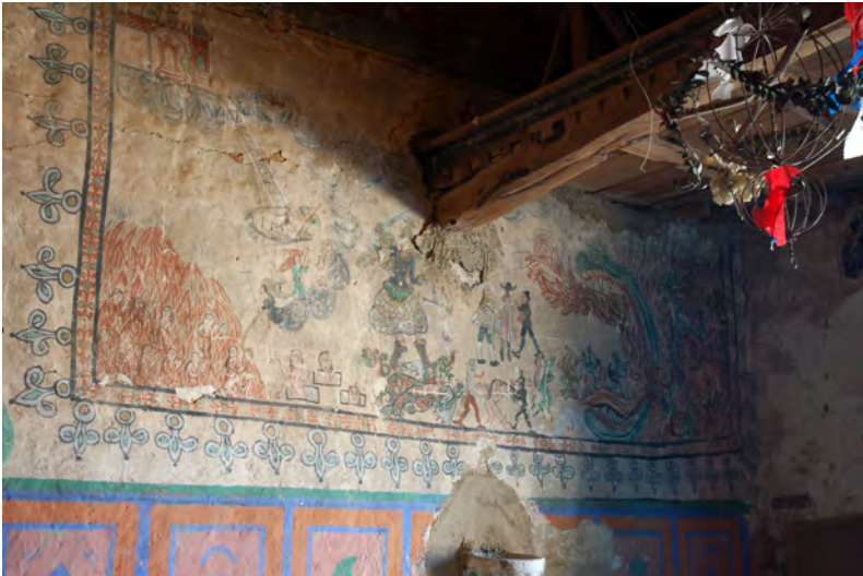
Instalación del coro y aplicación de estucos de hormigón sobre pinturas murales del siglo XVIII.
