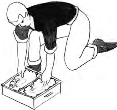
Arrojar el barro con fuerza dentro de la adobera, emparejar primero con las manos y luego con una regla de madera mojada
