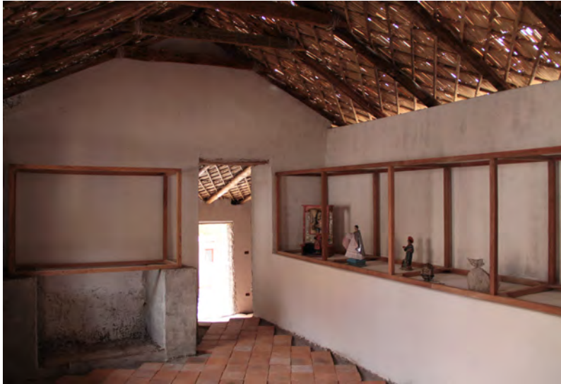
Proyecto en ejecución de museo y centro de interpretación patrimonial en el poblado de Esquiña. Tercera etapa y final de la restauración integral de la iglesia de San Pedro de Esquiña.
