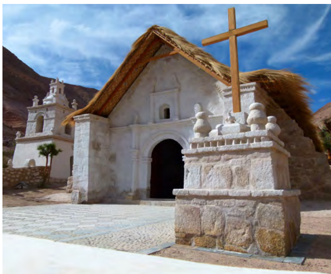
La iglesia de san Pedro de Guañacagua restaurada.
