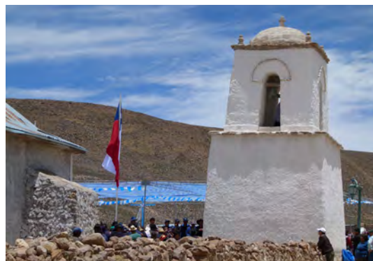
Restauración de la torre campanario del Santuario de Timalchaca.
